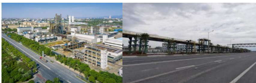
图 11-30 工业污水管网“下改上”架空铺设
