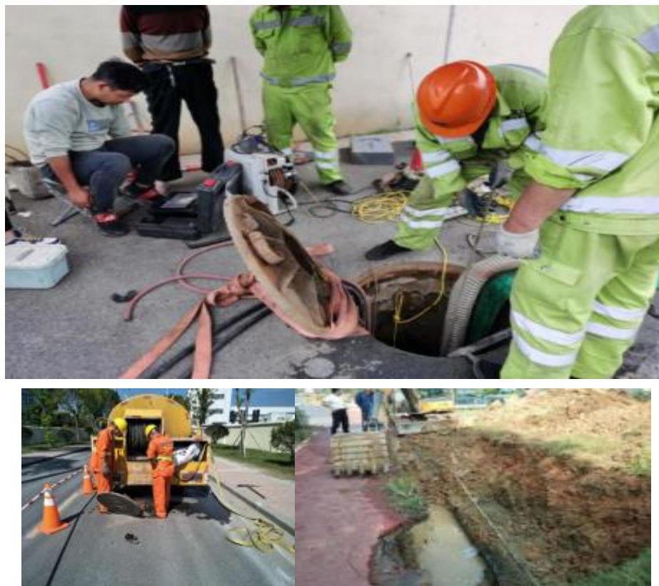
图 11-29 管网检测和修复
