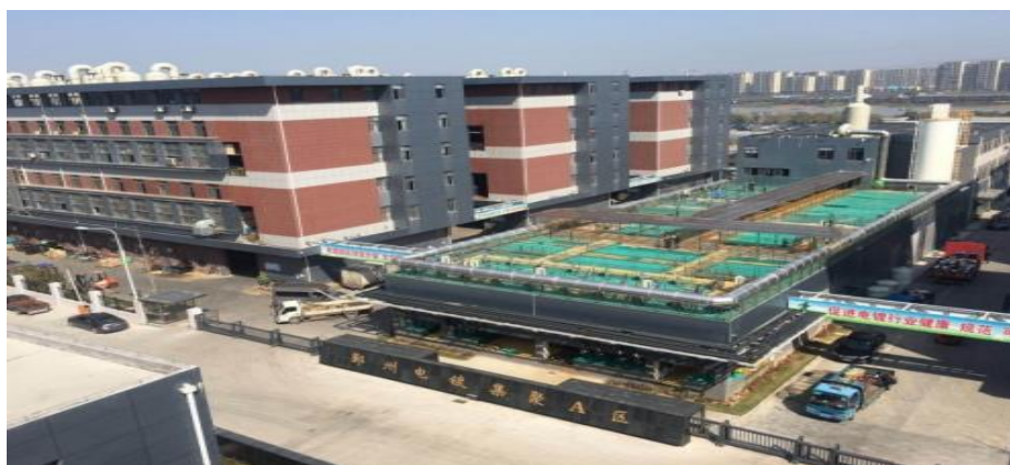
图 11-20 鄞州区电镀园区推倒重建
