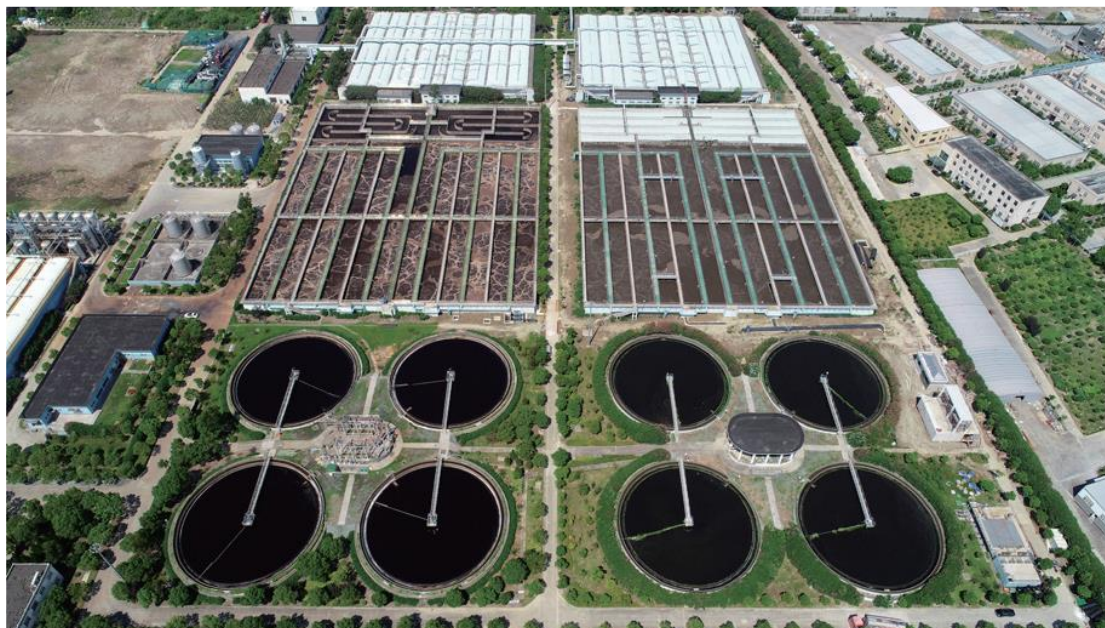
图 11-15 上虞经济开发区日处理量 20 万吨污水处理厂
