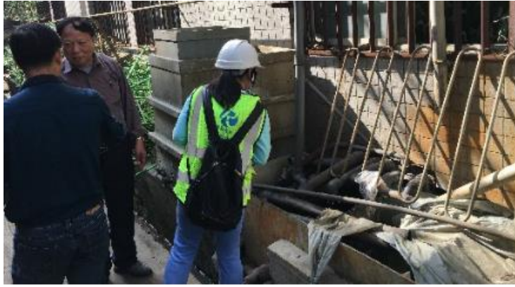
图 11-21 鄞州区电镀园区“污水零直排区”排查
