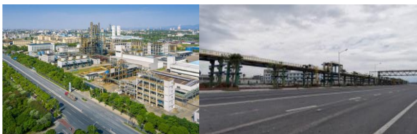
图 11-30 工业污水管网“下改上”架空铺设
