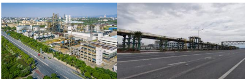
图 11-30 工业污水管网“下改上”架空铺设
